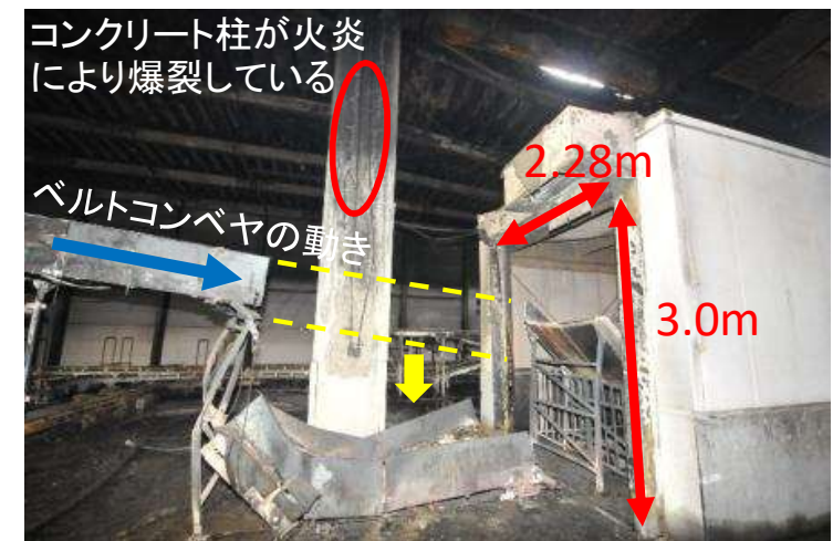
【端材室上部開口部(2階部分)付近】
